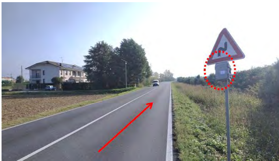
Figura 34 – Installazione apparecchiature per rilievo automatico sulla SP573 – direzione est
