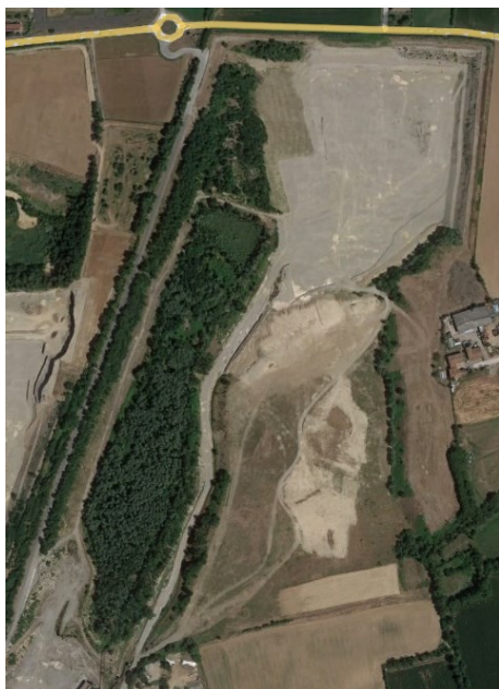
Ortofoto stato di fatto
