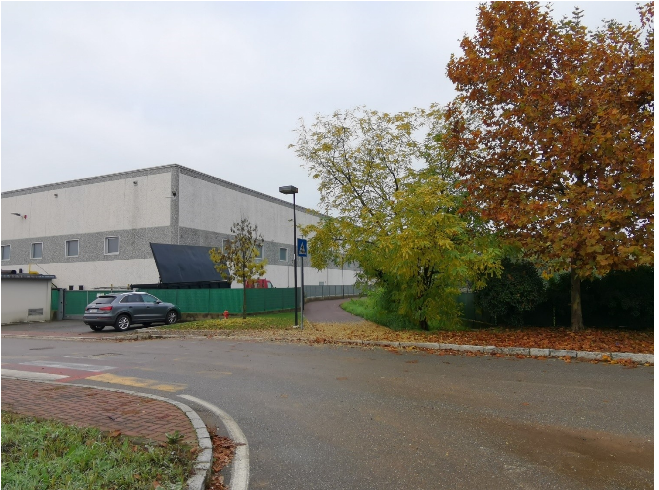
10 – Vista di via Gonzere da via Pontida
