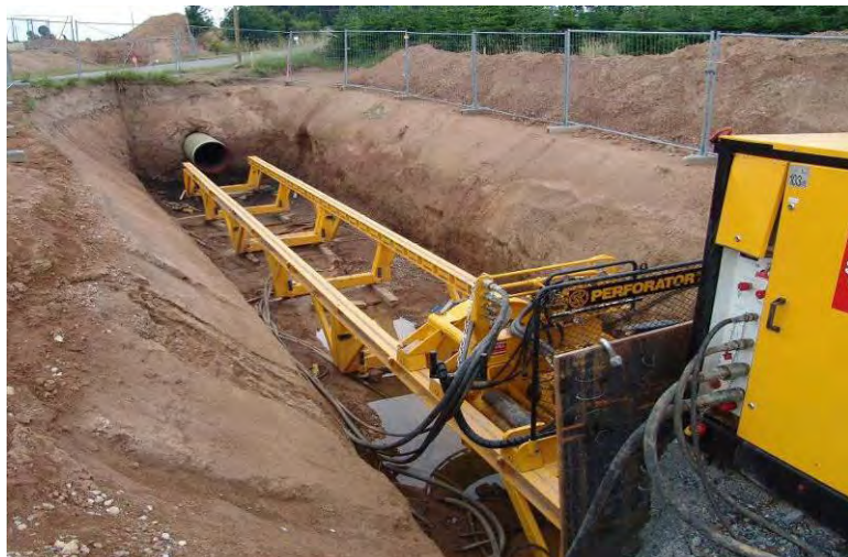
Tecnologia no dig
