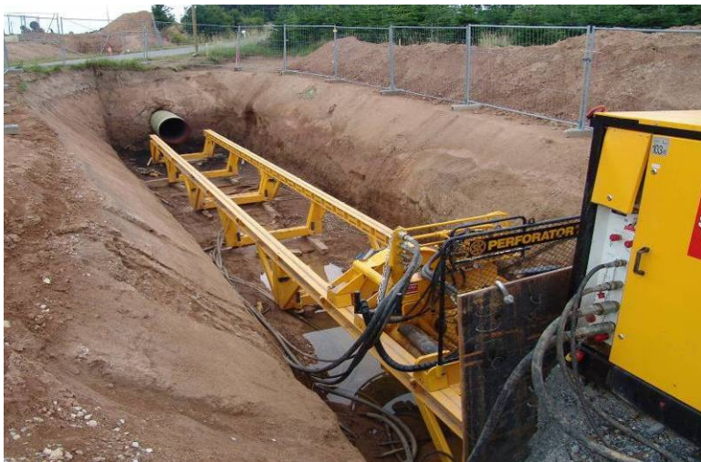
Tecnologia no dig
