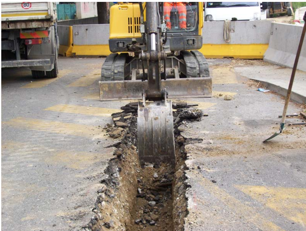
Esempio di trincea
