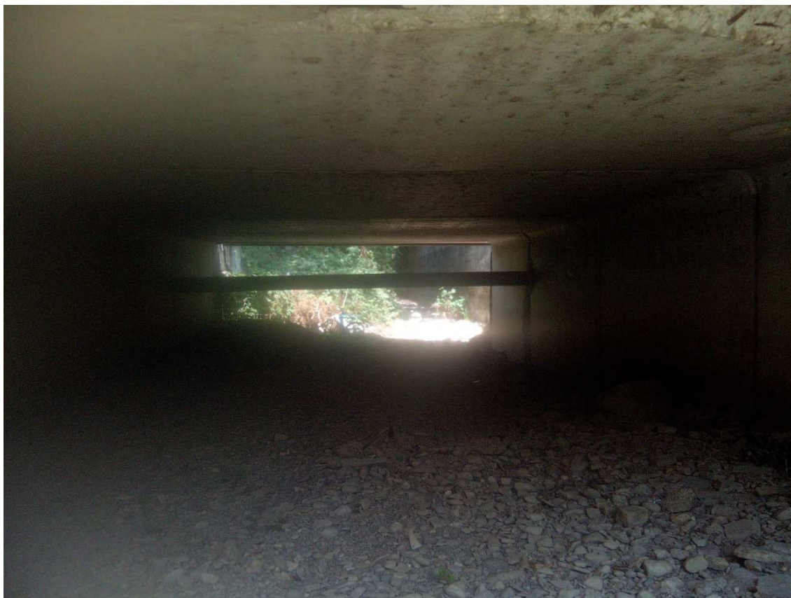
Figura 9.9 Vista da valle verso monte del ponte di Via G.B. Vezzoli (sezione 07)
