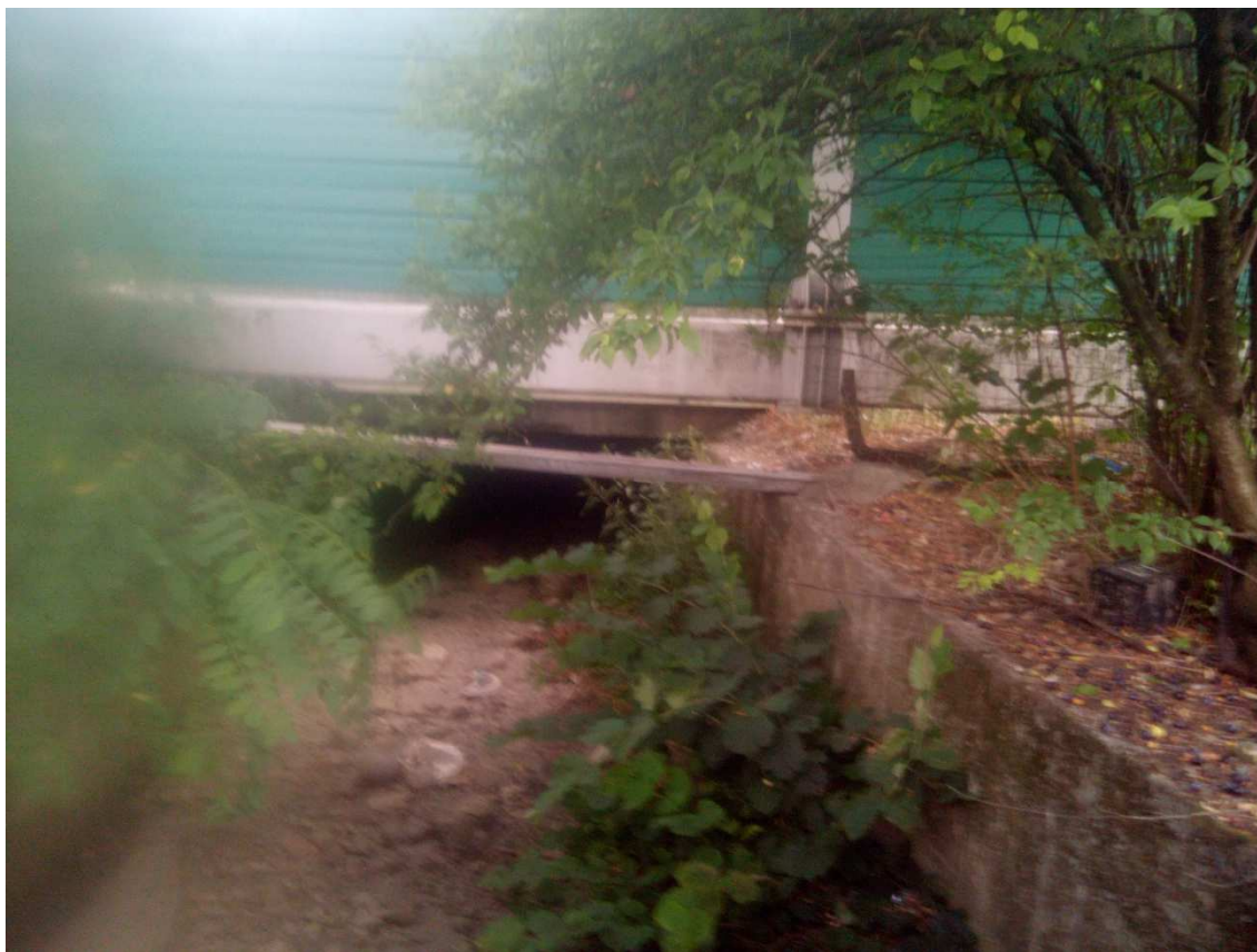
Figura 6.3 Attraversamento del Torrente Miola dell'autostrada A4: Scatolare 300x100 cm
