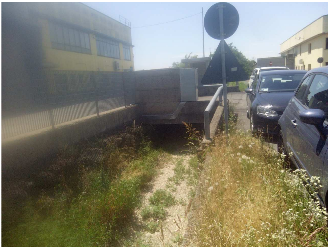
Figura 9.4 Vista da monte verso valle del ponte privato per l'accesso a un'azienda in Via Bornico (sezione 03)
