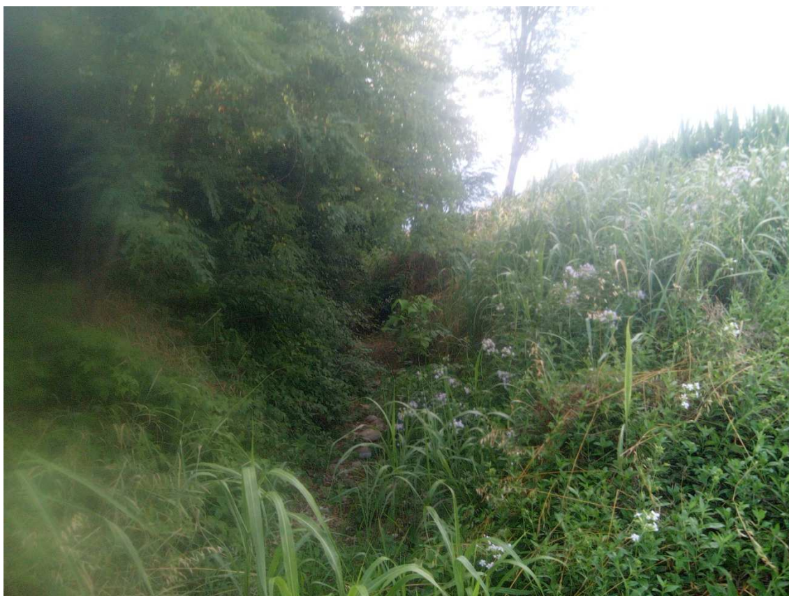
Figura 9.15 Vista da valle verso monte del Torrente Miola in corrispondenza della sezione 11
