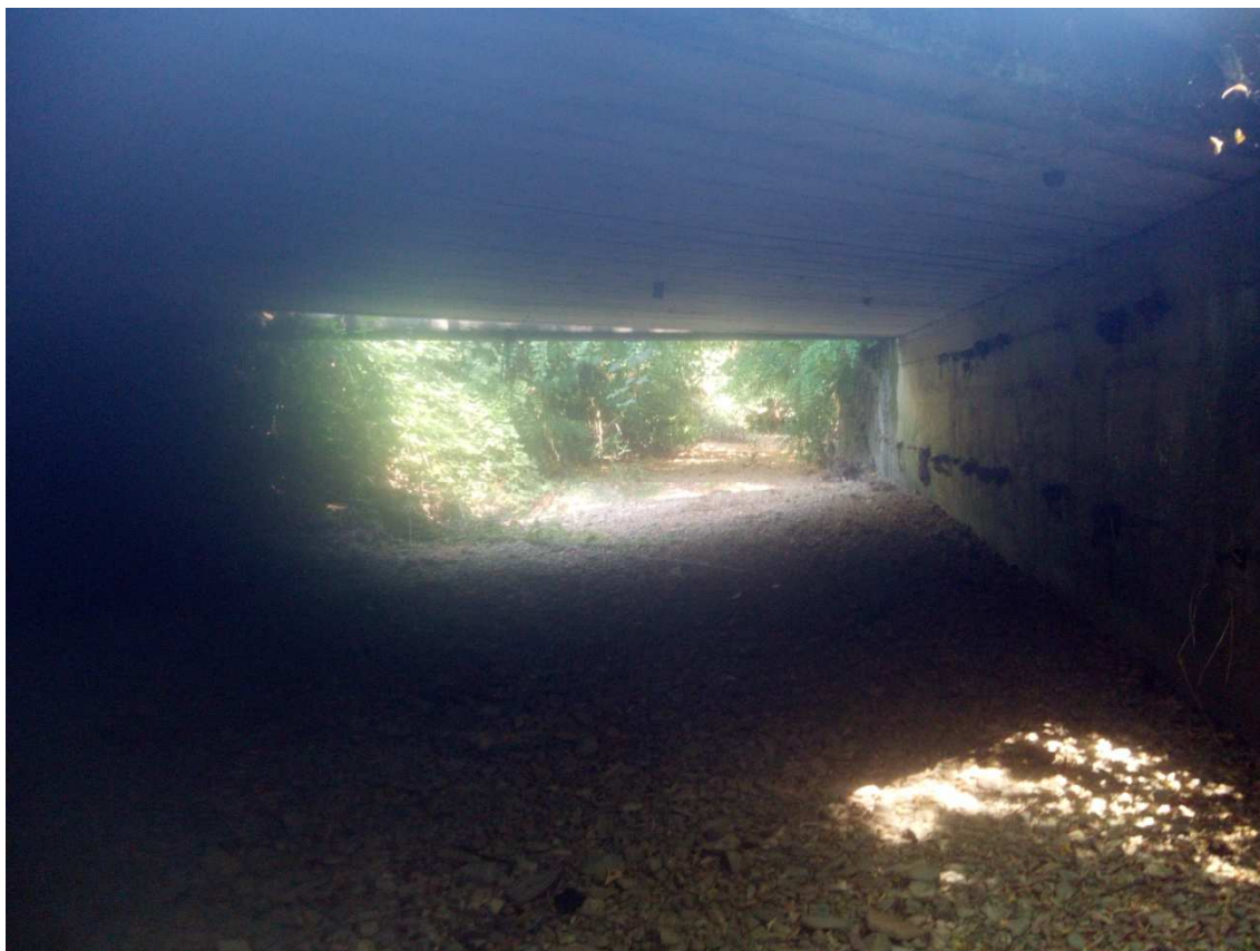
Figura 9.1 Vista da valle verso monte del ponte di Via Bornico (sezione 01)
