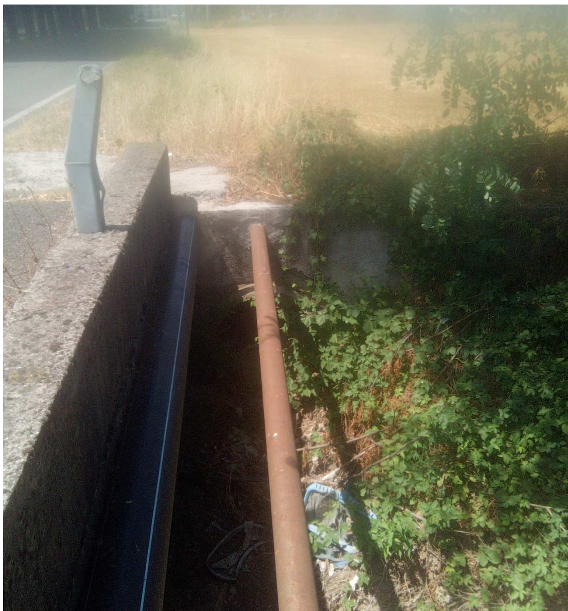
Figura 6.4 Sbocco del canale emissario dello scolmatore della rete fognaria di San Pancrazio nel Torrente Miola sul lato Nord di Via G.B. Vezzoli
