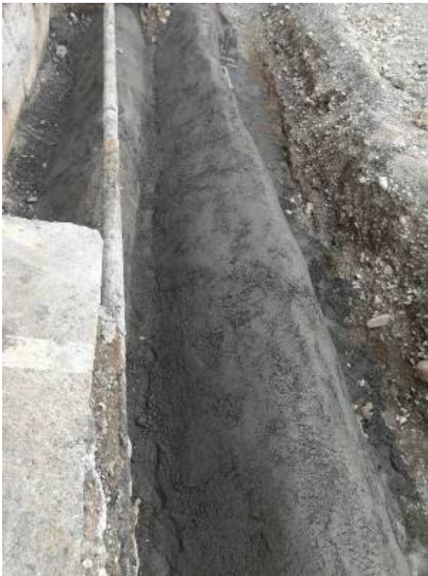
Fig. 12 Sigillatura finale e cementazione
