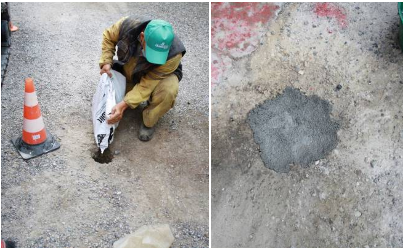
Fig. 8 Sigillatura del foro
