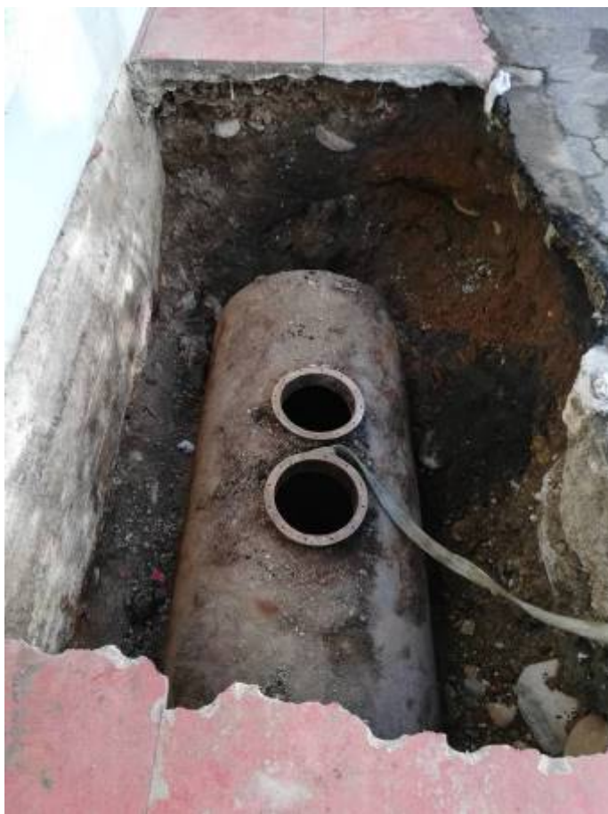
Fig. 13 Serbatoio da rimuovere
