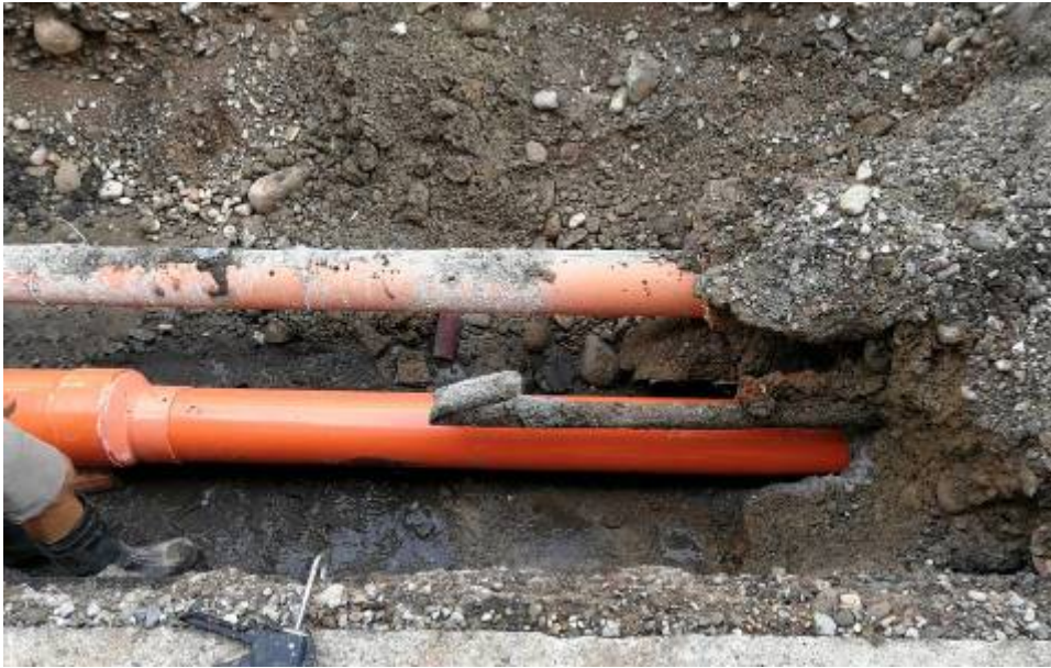
Fig. 11 Riparazione pluviale
