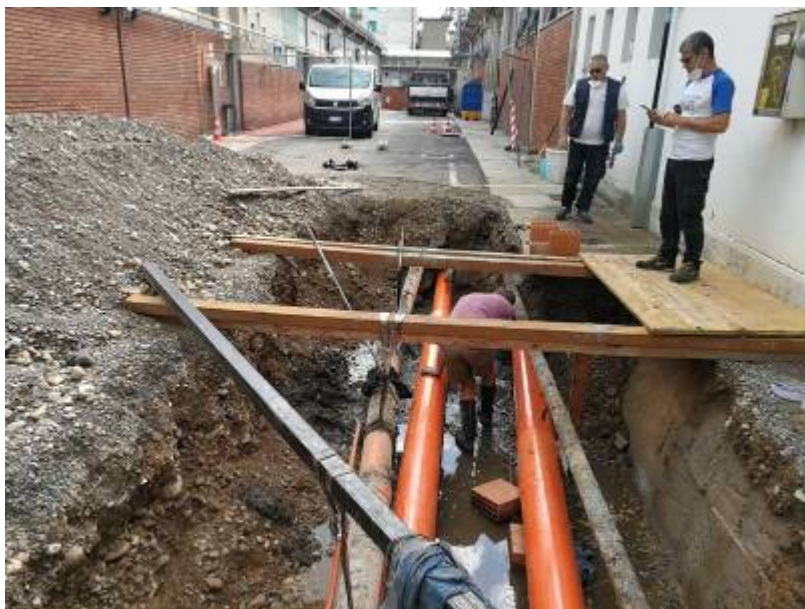
Fig. 10 Sostituzione delle linee
