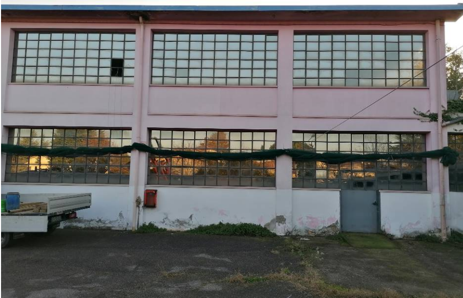
Fig. 11 Fabbricato di produzione (2)
