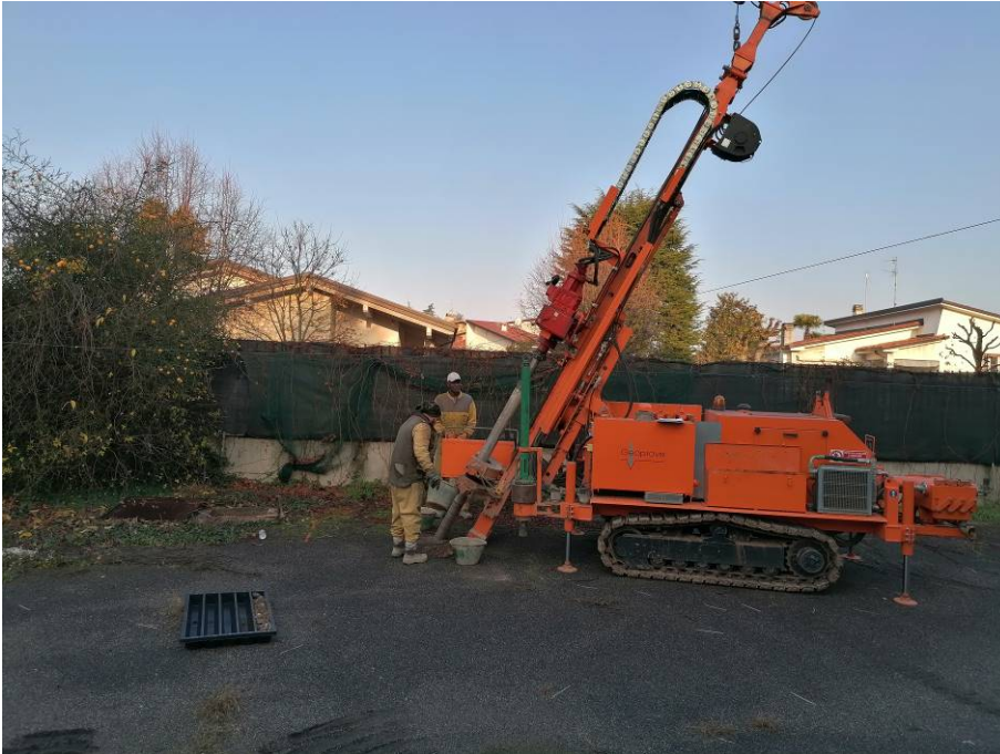
Fig. 19 Sonda geognostica Sondaggio inclinato S1
