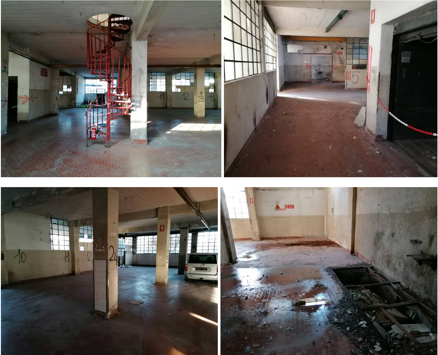
Fig. 12 Fabbricato di produzione (2)
