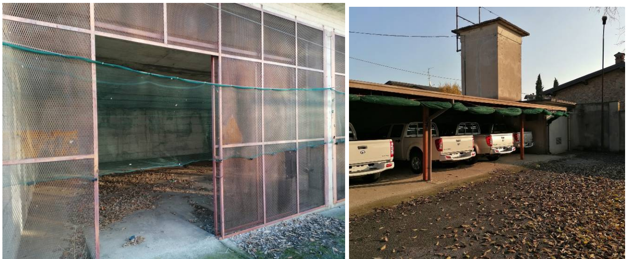
Fig. 16 Esposizione (6) e tettoia parcheggio (7)
