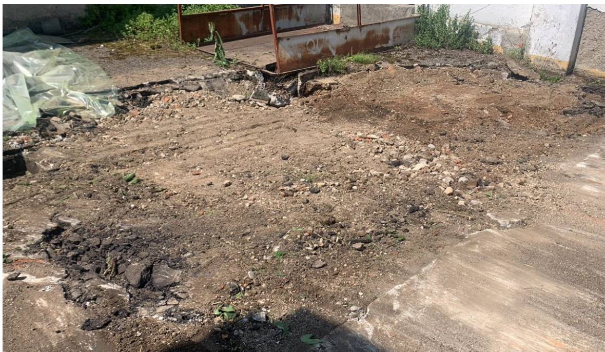
Fig. 4 Ripristino dello scavo al piano campagna
