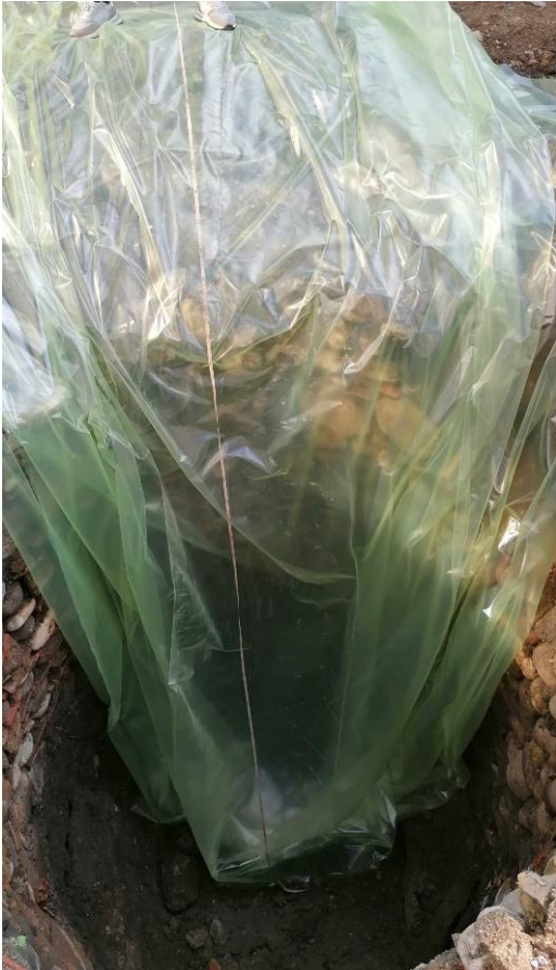
Fig. 2 Pulizia pozzo perdente completata
