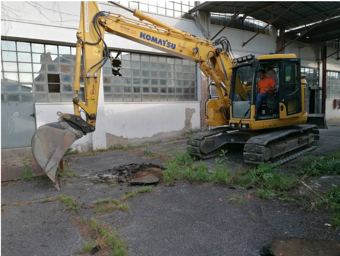
Fig. 1 Rimozione copertura pozzo perdente
