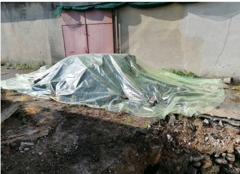
Fig. 3 Materiale accantonato in attesa di conferimento
