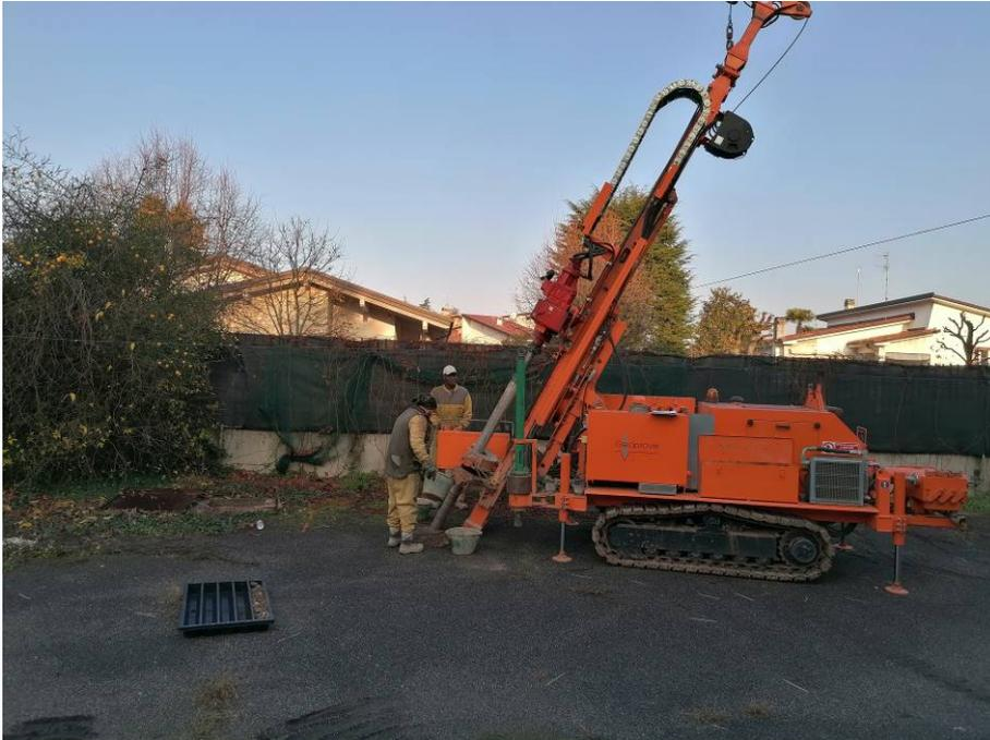
Fig. 16 Sonda geognostica Sondaggio inclinato S1
