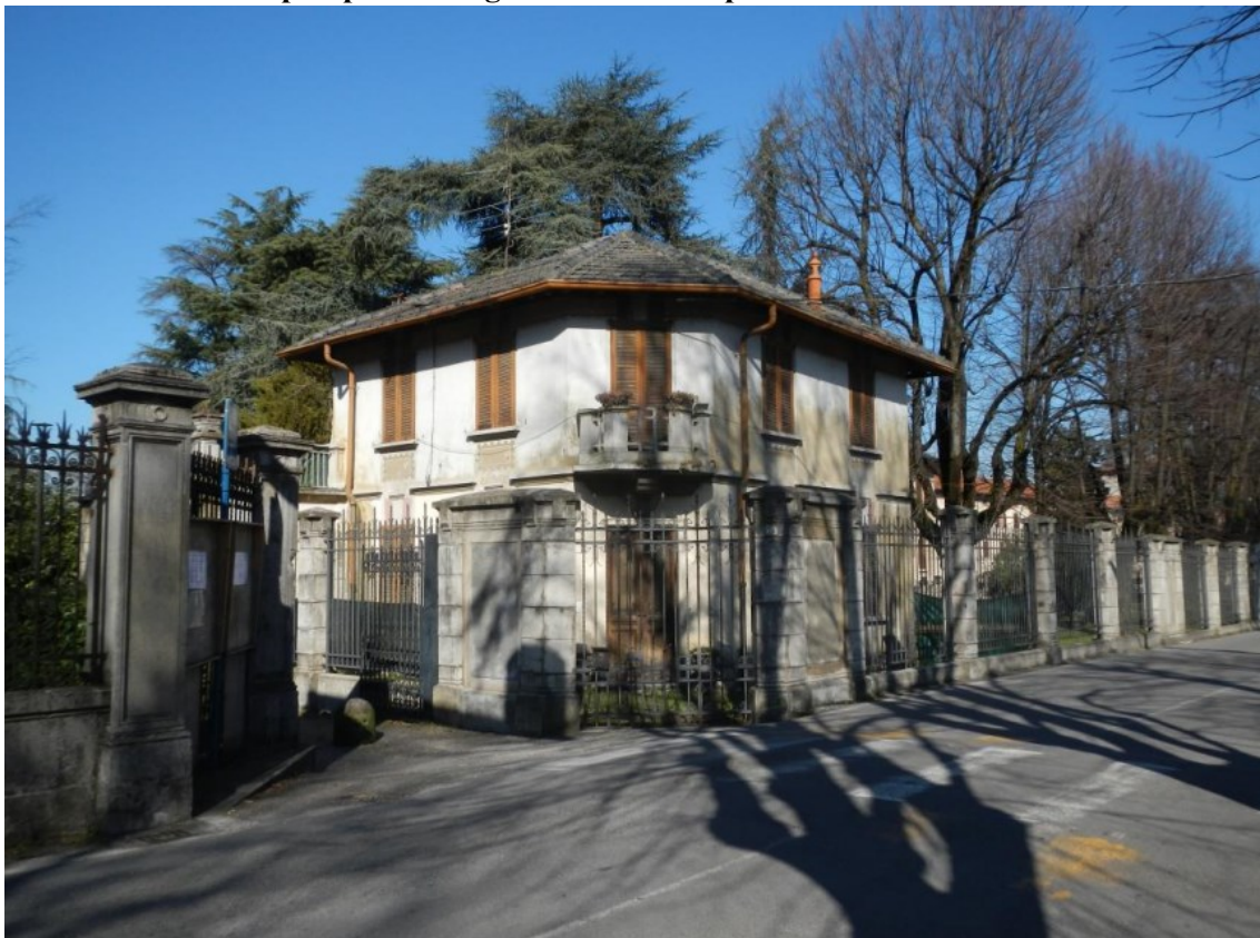
Foto del prospetto di ingresso del villino prima dei lavori di restauro
